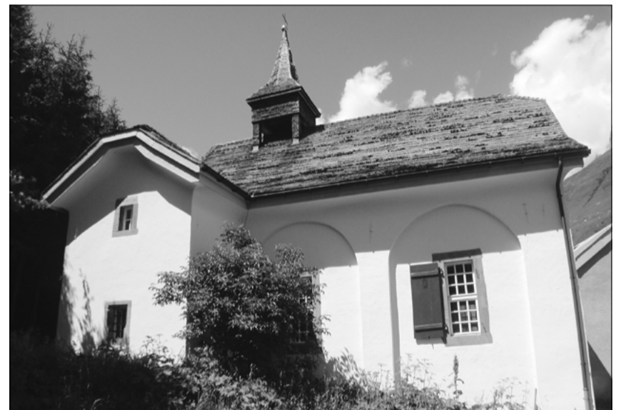
Die Kapelle St. Niklaus in Zumdorf ist renoviert. FOTO: ARCHIV UW
